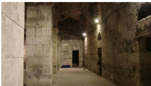
Fondations du Palais
